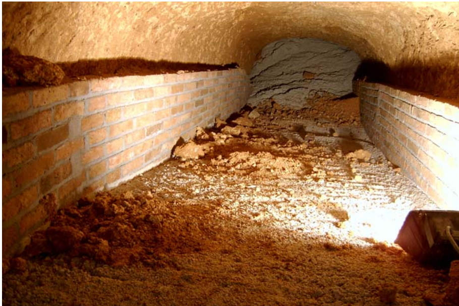
Fig.10 Vista general dels murs i la volta de la galeria.
